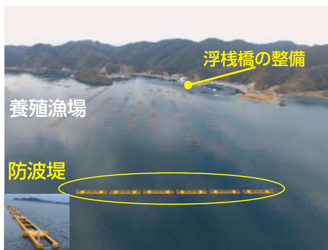
整備が進む養殖漁場を守る防波堤と浮棧橋
