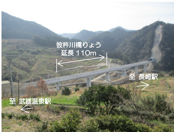
竣工した「彼杵川橋りょう」工区
