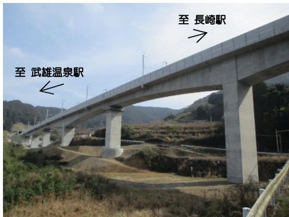
竣工した「彼杵川橋りょう」工区
