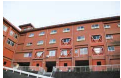
私立学校の耐震化(耐震補強)
