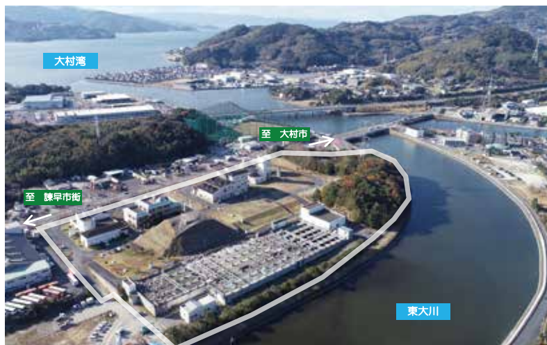
大村湾南部浄化センター
