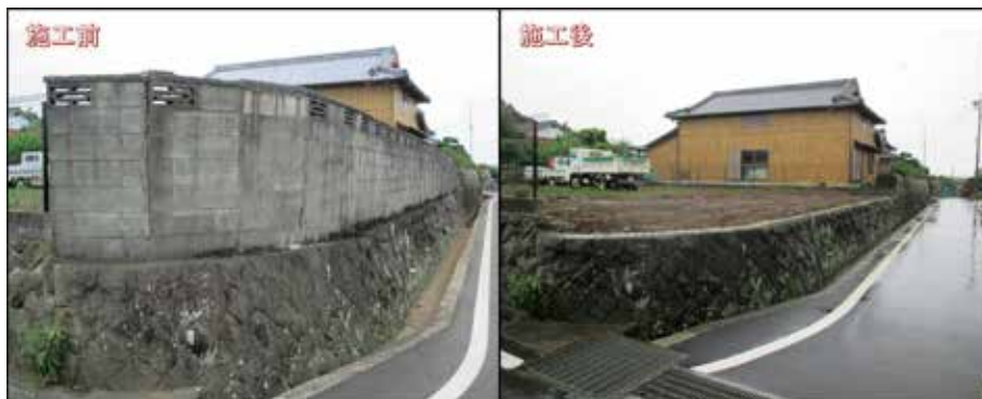
危険ブロック塀除去事例
