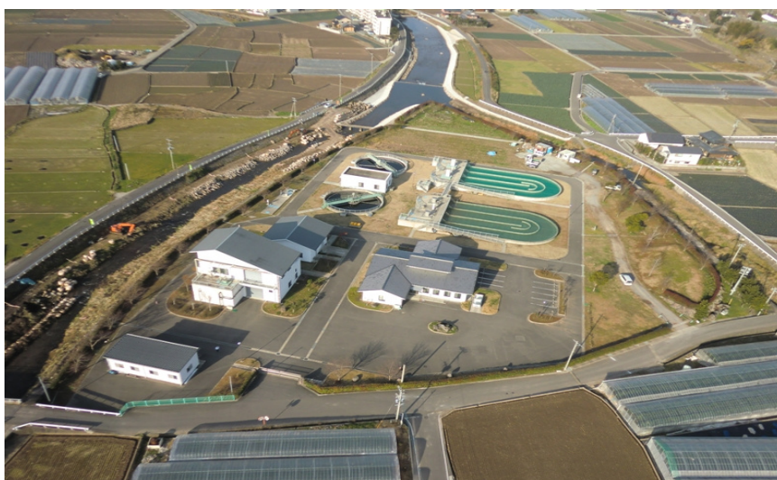
千々石浄化センター 提供:雲仙市
