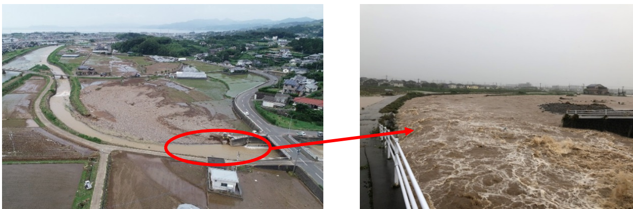
図 5 7 本県における豪雨災害（令和 2 年(2020 年)7 月豪雨 大村市）堤防が一部決壊
