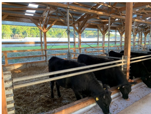
図 5-5 扇風機設置の畜舎
