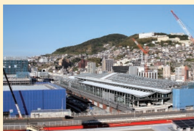
既に開業した在来線の駅舎に引き続き、新幹線の駅舎が建設中の長崎駅(右)周辺ではMICE施設などの整備も進む
