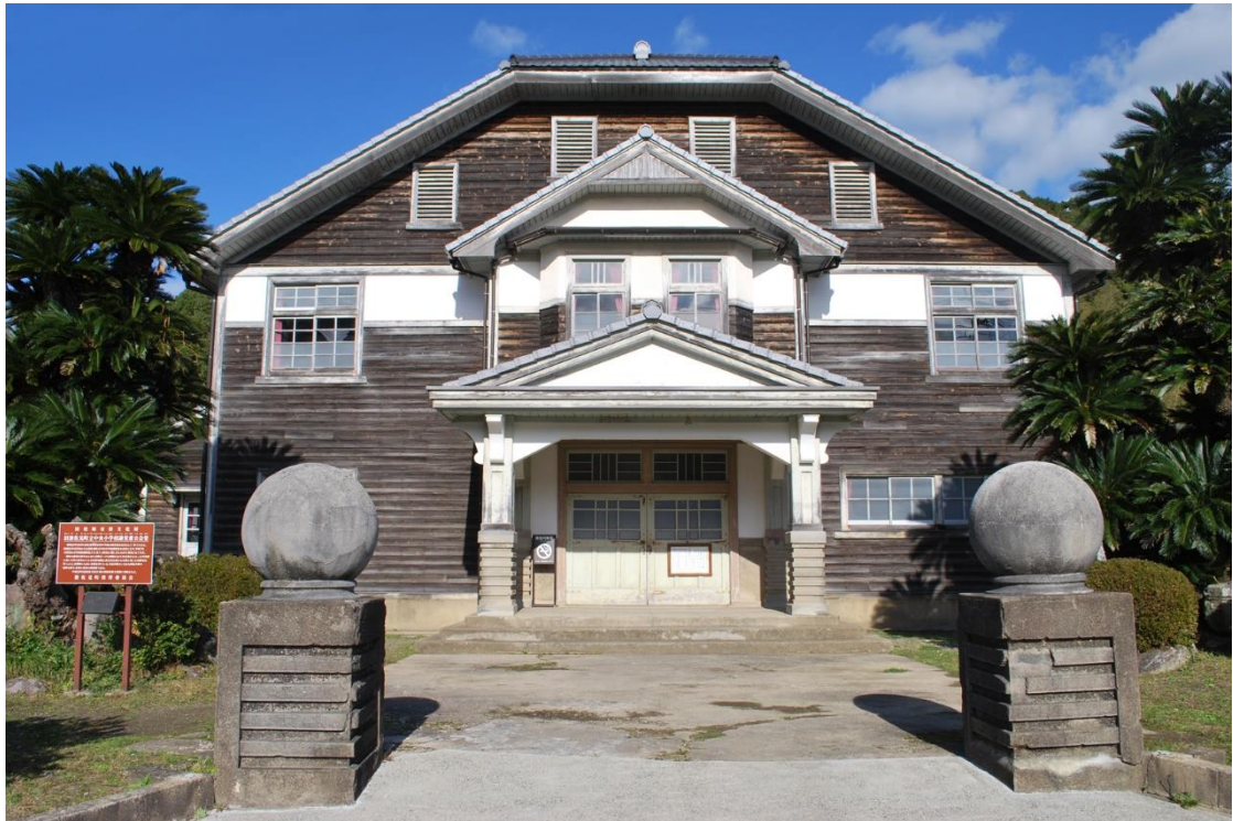
旧波佐見町立中央小学校講堂兼公会堂（波佐見町）
