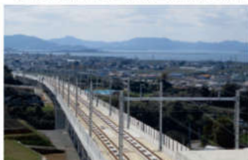
大村市内の進捗状況(R2.3撮影)
