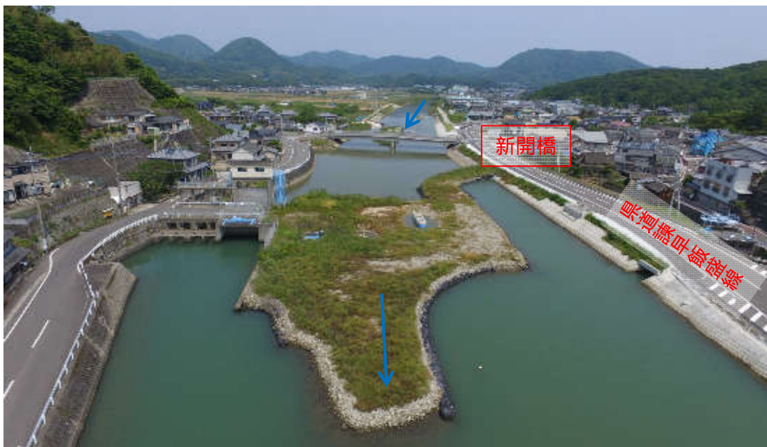
江ノ浦川河川改修工事（施工状況）
