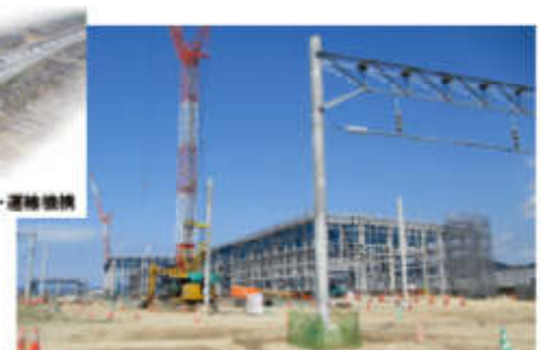
大村車両基地の進捗状況(R2.3撮影)
