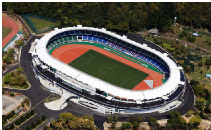
第69回長崎国体の開閉会式及び陸上競技が行われた県立総合運動公園 （写真中央：トランスコスモスタジアム長崎）
