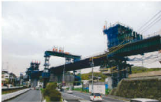
諫早市 宇都橋りょう(R2.4撮影)
