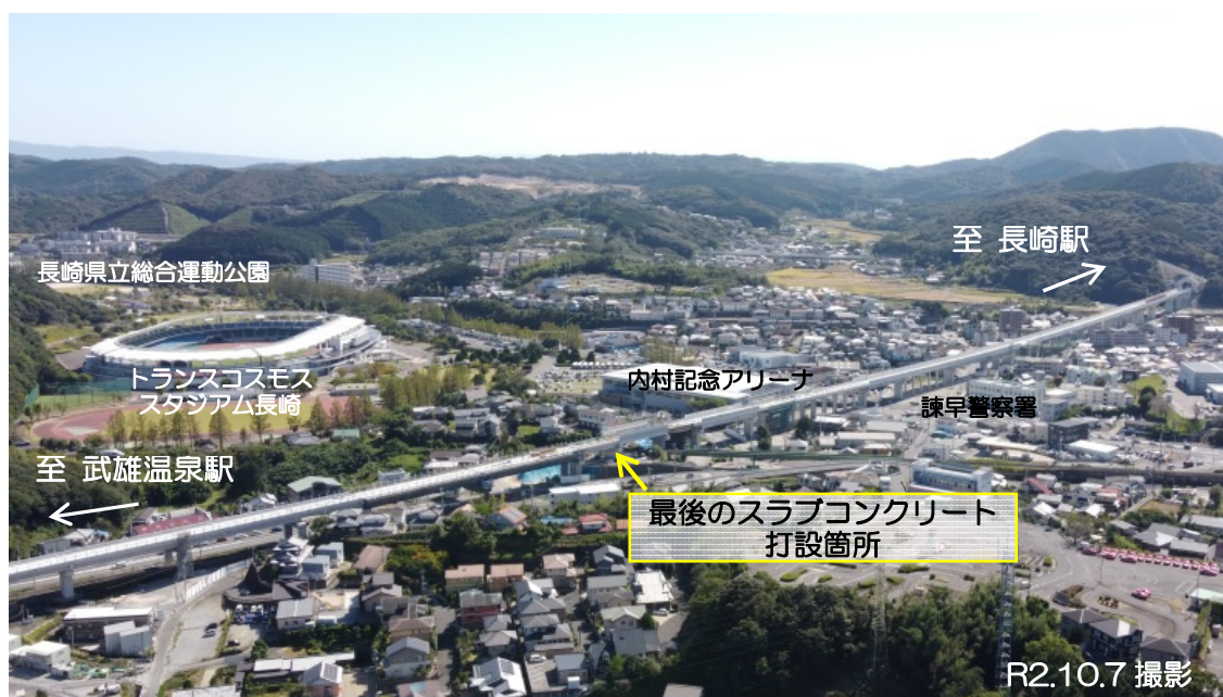
諫早市の御館山から見た新幹線の様子
