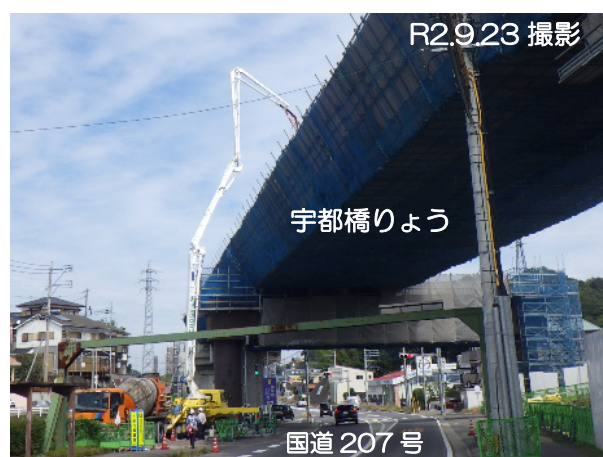
スラブコンクリート打設状況
