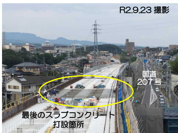
スラブコンクリート打設完了状況
