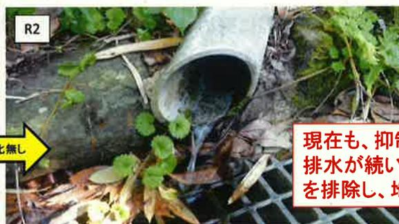
現在も、抑制工(集水井工)からの排水が続いており、安定して地下水を排除し、地すべりを抑制できている。
