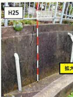
地すべりによって外壁、舗装等にクラックが入っていたが、対策を行った結果、概成後5年以上経過した現在でも、補修したクラックの再発は見受けられず、地すべり対策事業の効果が発現されていることが見受けられる。
