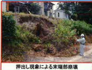
押し出し現象による末端部崩壊
