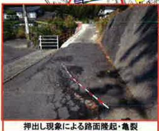
押し出し現象による路面隆起・亀裂
