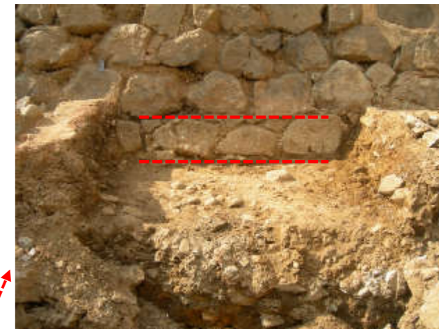
<石垣の根石検出状況> 横のラインが水平になっていることから、1610年代に積まれた一番古い石垣と考えられています。
