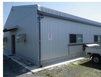
写真-5 対策3 種鶏舎の新築
