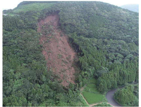
地すべりによる被災状況（令和元年 松浦市）
