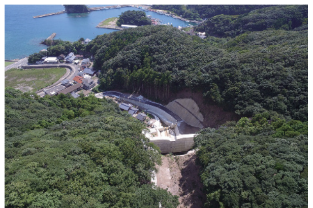
人家、道路を保全している砂防堰堤(対馬市)
