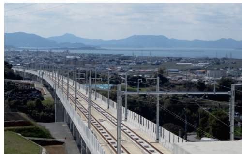
大村市内の進捗状況(R2.3撮影)
