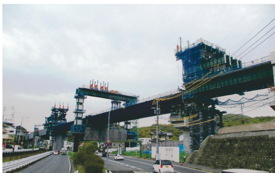
諫早市 宇都橋りょう(R2.4撮影)
