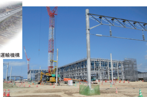
大村車両基地の進捗状況(R2.3撮影)
