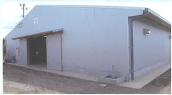
整備牛舎(外観)
