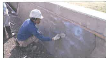
(老朽化した水路壁のコーティング)
