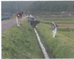
(水路法面の草刈施工)
