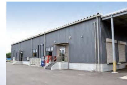
2019年に五島市三井楽町濱ノ畔に建設した加工場兼事務所
