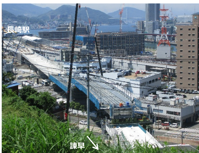
移動後の状況 (R2.6.16 撮影)
