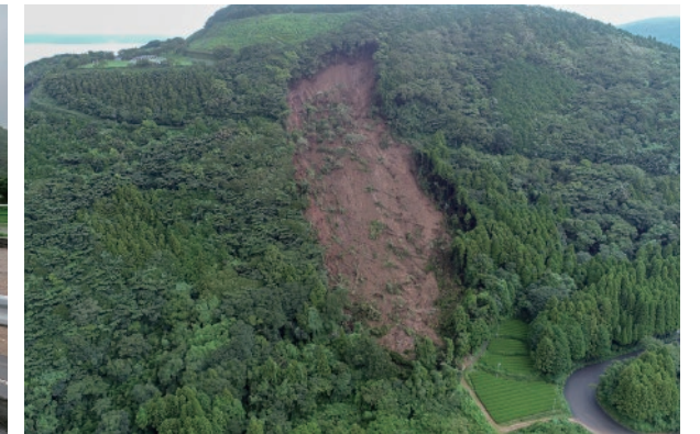
令和元年8月27日 高野地区地滑り（松浦市）
