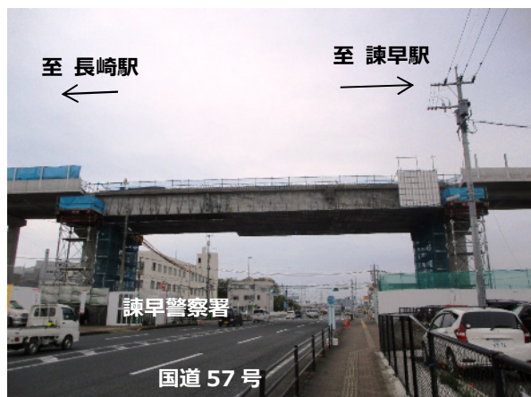
第2平山架道橋の架設状況 【R2.4.21撮影】
