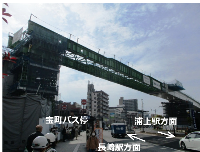
架設状況 (R2.4.15 撮影)
