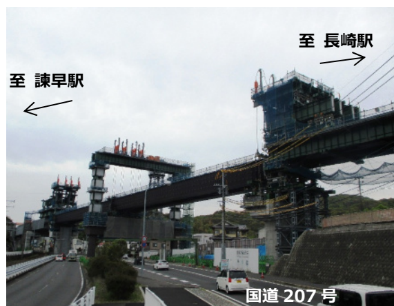
宇都橋りょうの架設状況 【R2.4.21撮影】
