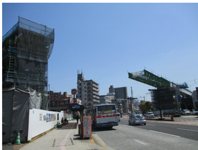
架設状況 (R2.4.14 撮影)
