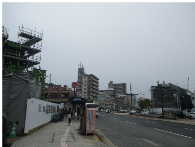
架設状況 (R2.3.31 撮影)
