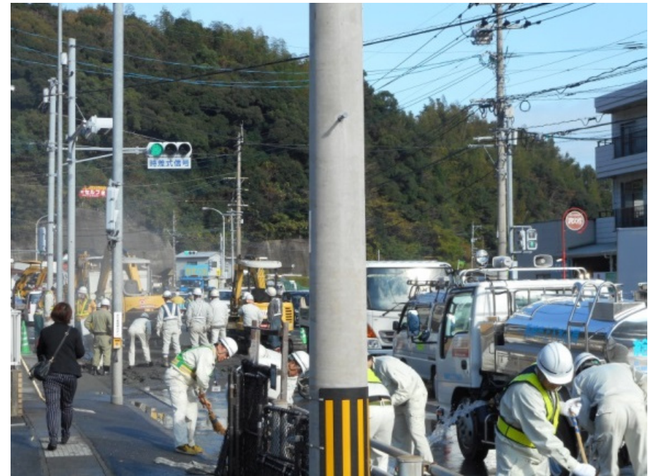
水道管破損事故復旧状況
