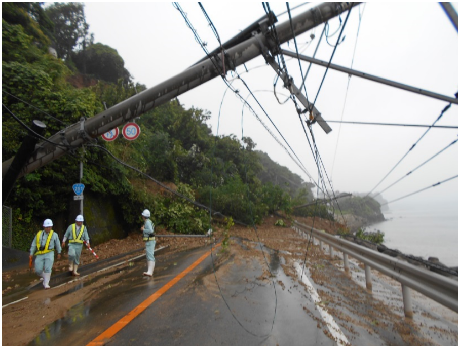
大雨による被災状況
