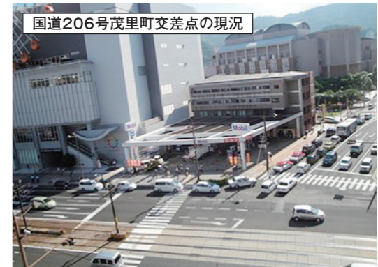
国道206号茂里町交差点の現況 踏切により渋滞が発生し、国道まで影響しています。
