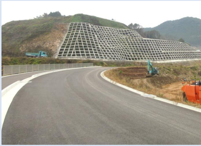
付替県道の一部完成区間
