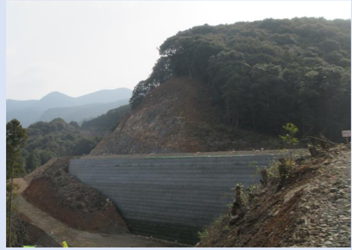
付替県道の施工状況
