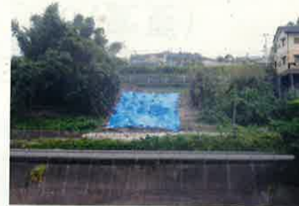
⑥線路沿い法面崩壊
