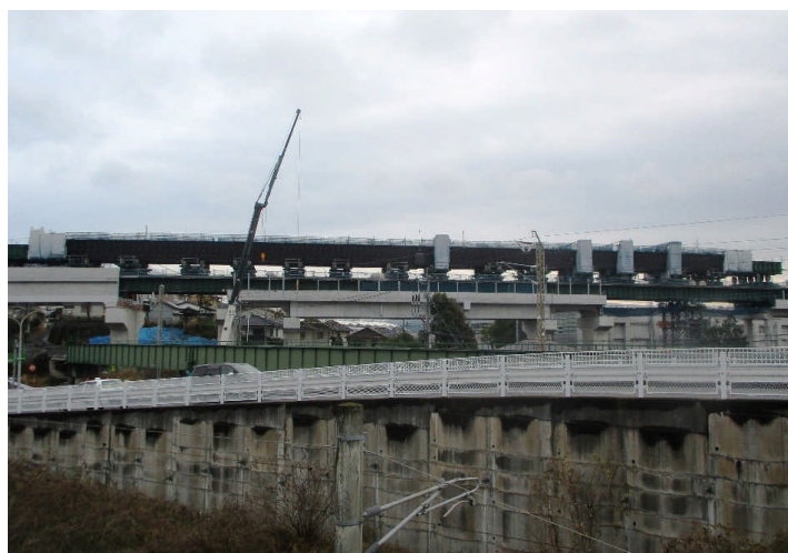
製作・運搬され、架設準備中の宇都橋りょう
