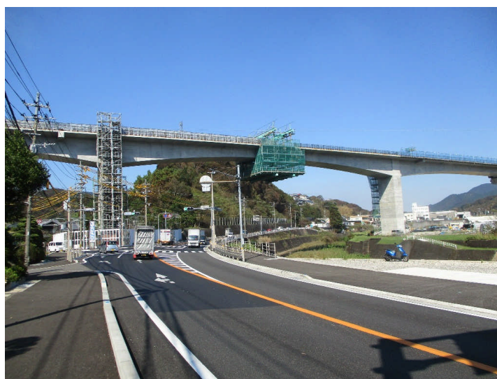
【閉合した八郎川橋りょう】
