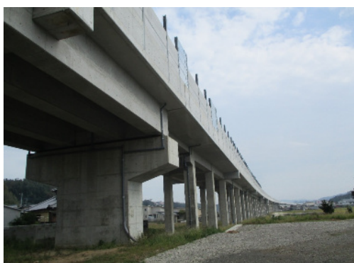
完成した「栄田高架橋他」工区
