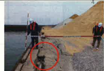
・施設老朽化状況写真 舗装工ひび割れ状況
