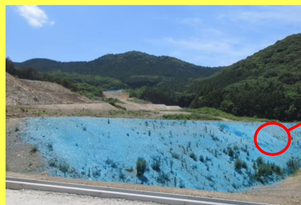
種子を吹付けた直後(吹付箇所が確認できるよう水色で表示しています。)
