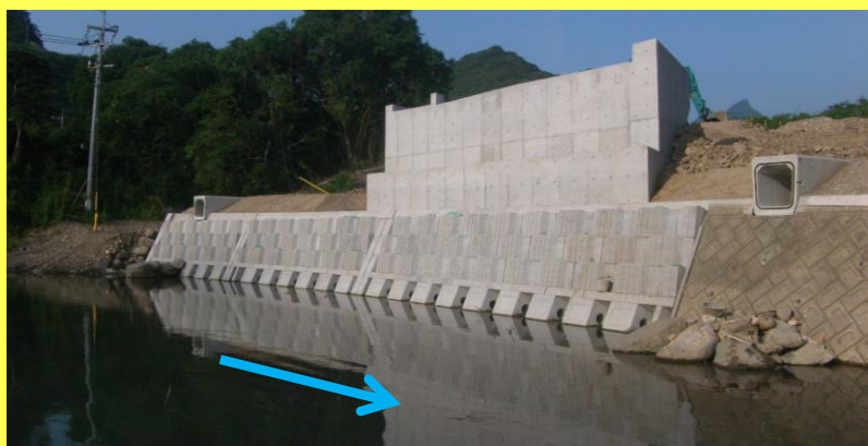
付替県道に必要な橋梁の橋台を施工中です。
