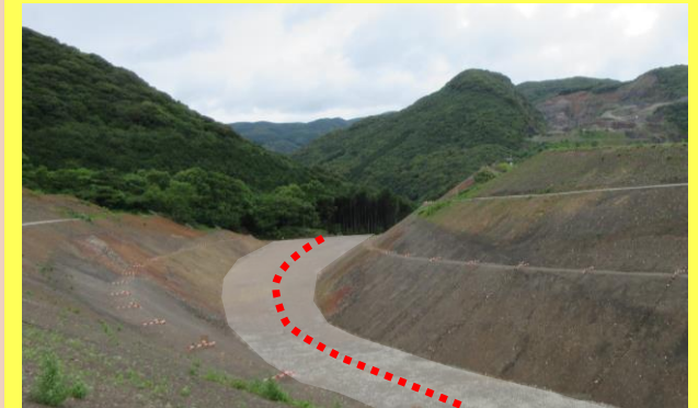
切土工区 法面の現況
