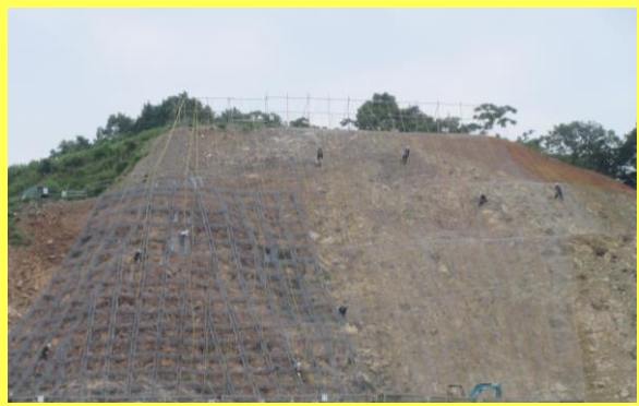
切土法面の施工状況
