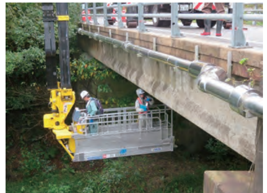
橋梁の定期点検状況
