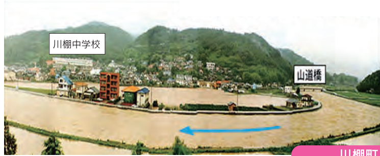
平成2年水害（H2.7.2）の被災状況
