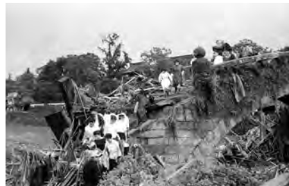
諫早大水害（S32.7.25）の被災状況
