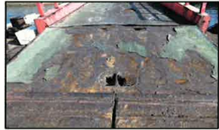
陸揚げ用浮栈橋が腐食し、施設利用に支障をきたしている。(水崎漁港)
