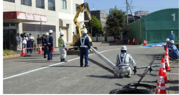
バックホウによる電柱撤去
