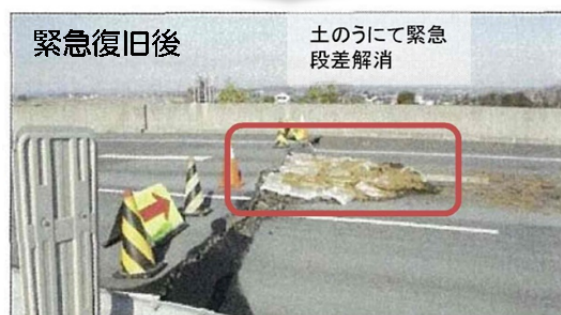
東日本大震災時の緊急復旧状況
