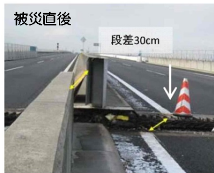
図 4.18 橋梁段差解消に向けた配備イメージ
