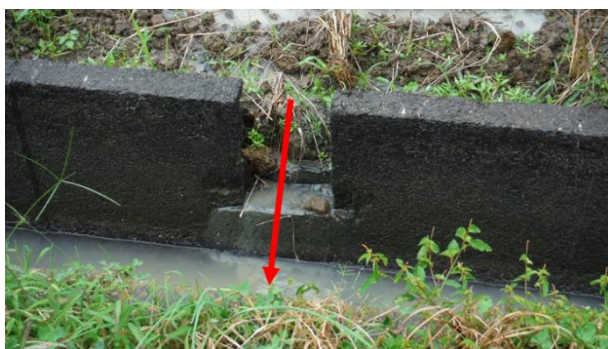
図5 畑地の水抜き用の穴(赤矢印は流出水の流れ)
