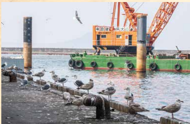
多くのカモメが現場に「落し物」をしていた。作業も大変だ。
