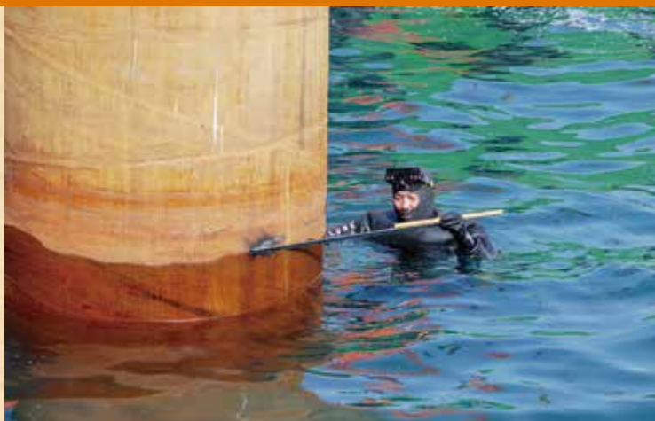
潜水士は測量の手伝い、海中、海上の溶接をしていた。
