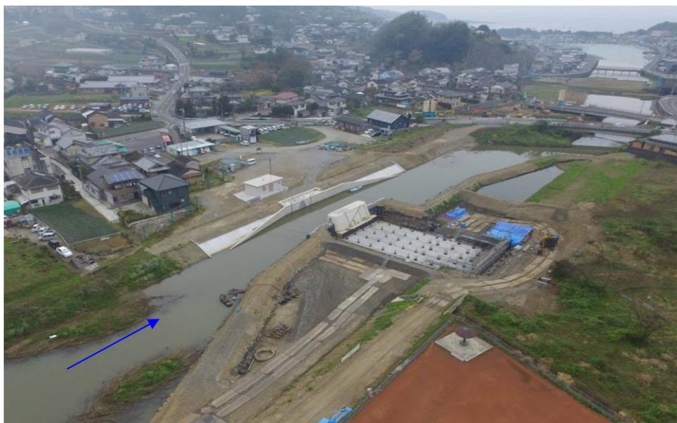
江ノ浦川河川改修工事（潮止堰施工状況）
