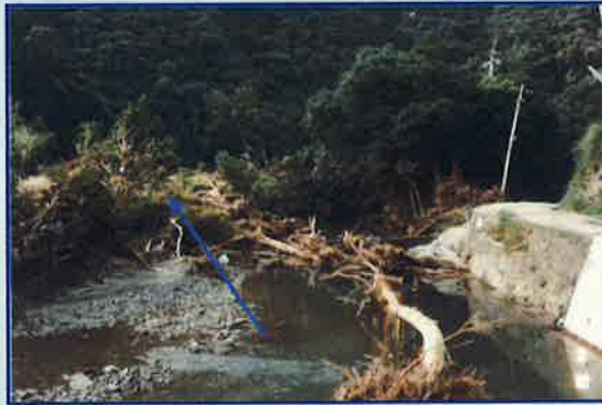
水道局跡地付近
