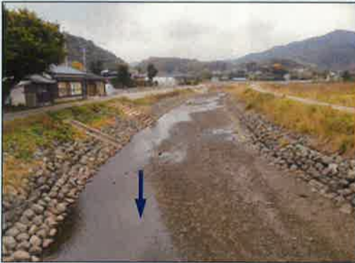
浜添橋：上流側
