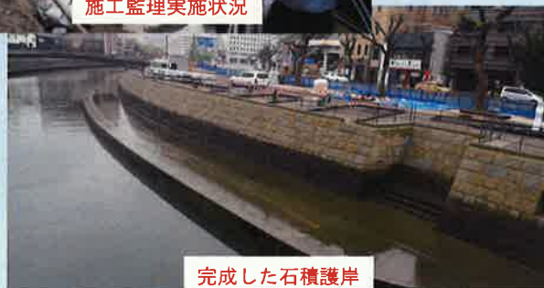
施工監理実施状況
