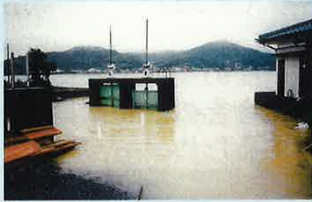
国道より上流（右岸）
