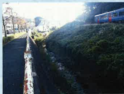
2k380付近 (未改修)
