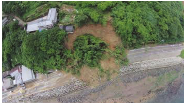
国道251号 土砂災害状況 平成27年6月
