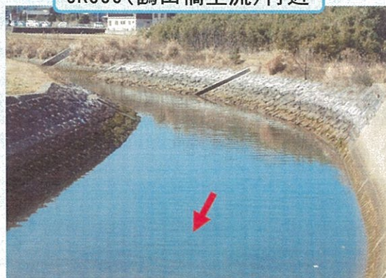
0k600(鶴田橋上流)付近
