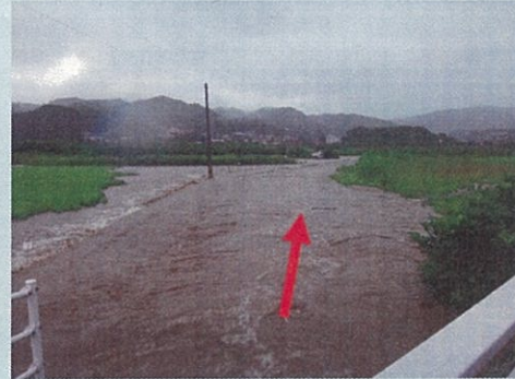
1k100 (山本橋下流) 付近
