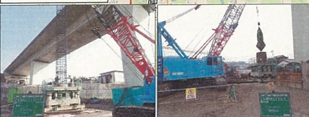
出平IC周辺の工事状況
