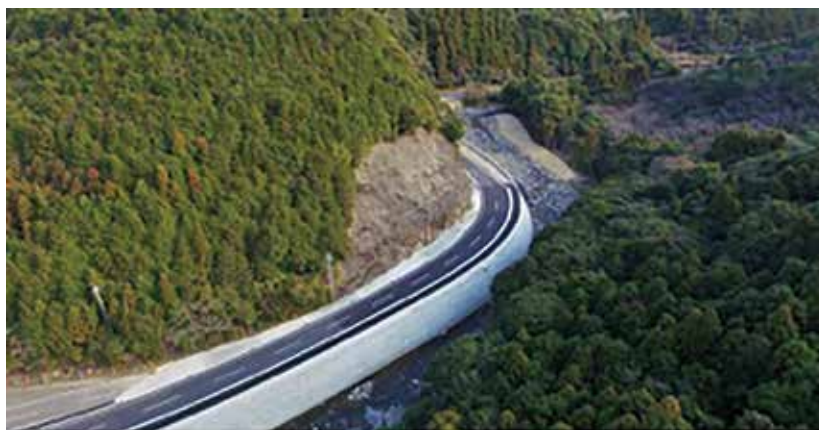
改良工事が進む 一般県道玉之浦岐宿線 幾久山工区
