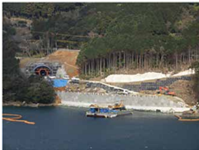
改良工事が進む 国道384号 三日ノ浦バイパス
