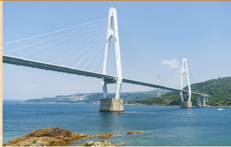
大島大橋全景。見晴らしがいいだけに風も強く、橋桁は風の影響を受けにくい形状になっている。
