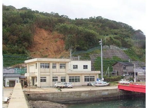
人家裏の斜面が崩壊(平成18年 五島市)
