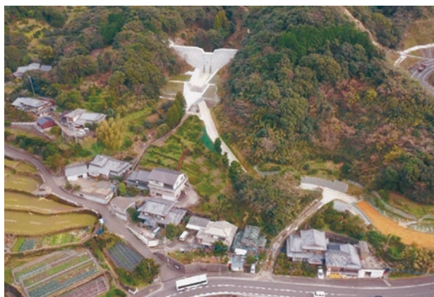
人家や公民館、道路を保全している砂防堰堤(長崎市)
