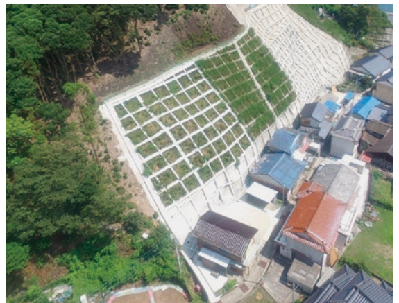
斜面下部の多くの人家を保全している法面工(対馬市)
