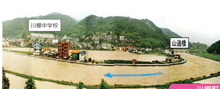
平成2年水害 (H2.7.2) の被災状況
