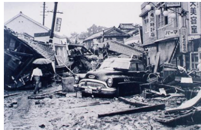
諫早大水害 (S32.7.25) の被災状況
