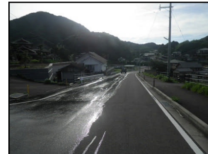
道路路面洗浄状況
