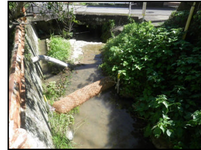
パームロール設置状況
