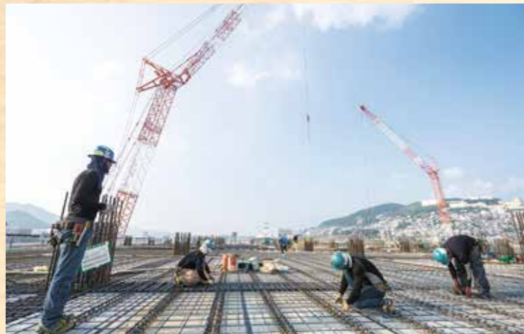
現場の作業風景。様々な国から集まった方々が働いていた
