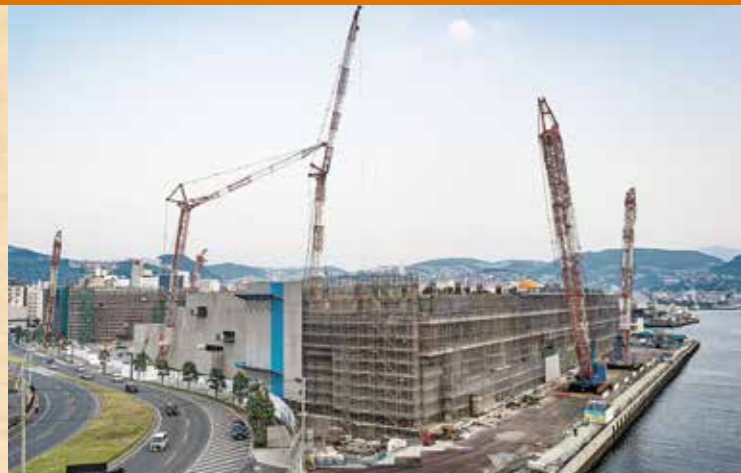
旭大橋の歩道から工事中の現場を間近で見ることができる
