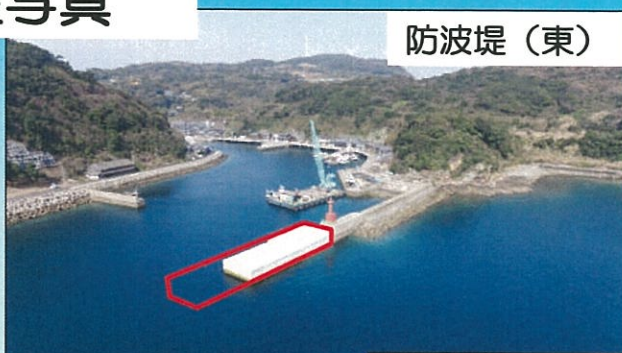
物揚場(-3.0m)(突堤)
