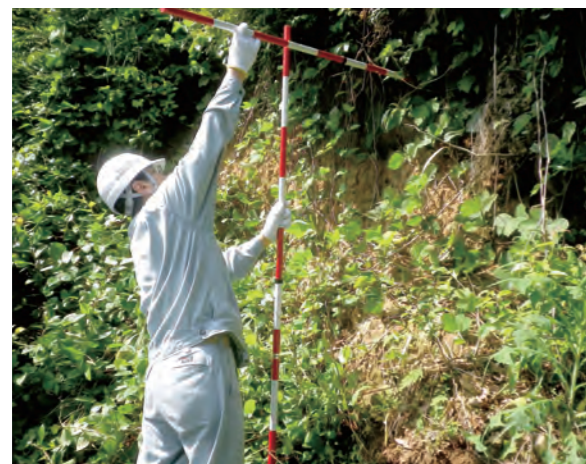
斜面危険箇所調査状況
